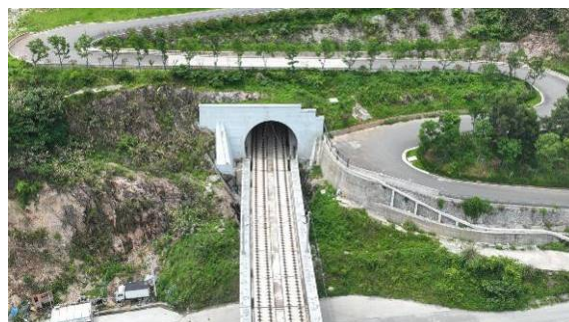
盐盆山 1 号隧道入口
