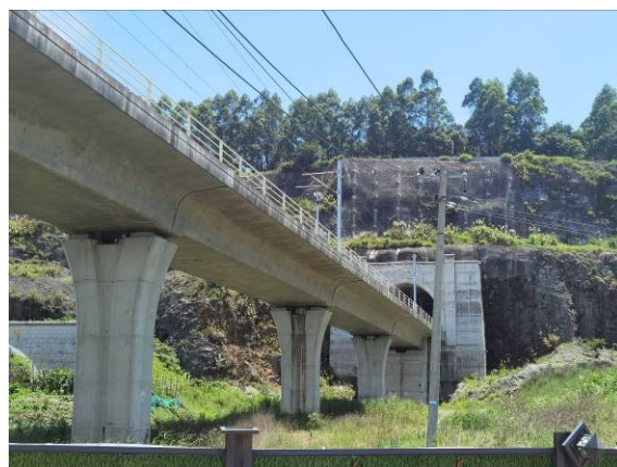
前岗山隧道入口
