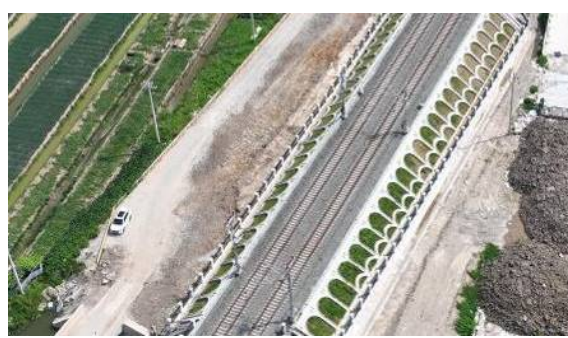
路基边坡绿化
