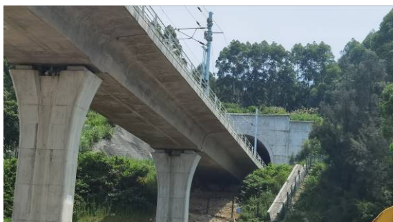
前岗山隧道出口
