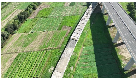
瓯江南口地下明挖段
