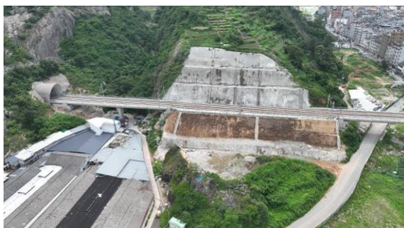
盐盆山 1 号隧道出口
