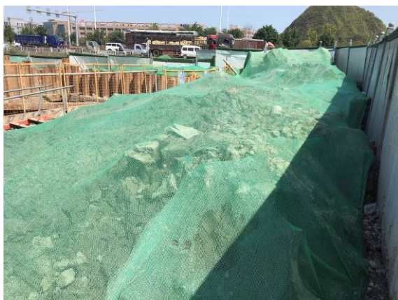
临时拦挡、苫盖
