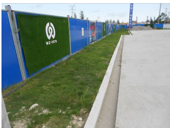
临时绿化、排水
