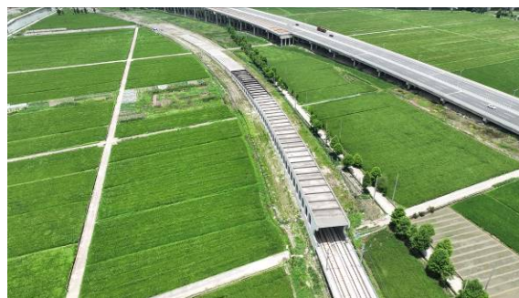
瓯江北口地下明挖段
