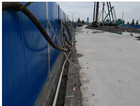
临时拦挡、排水
